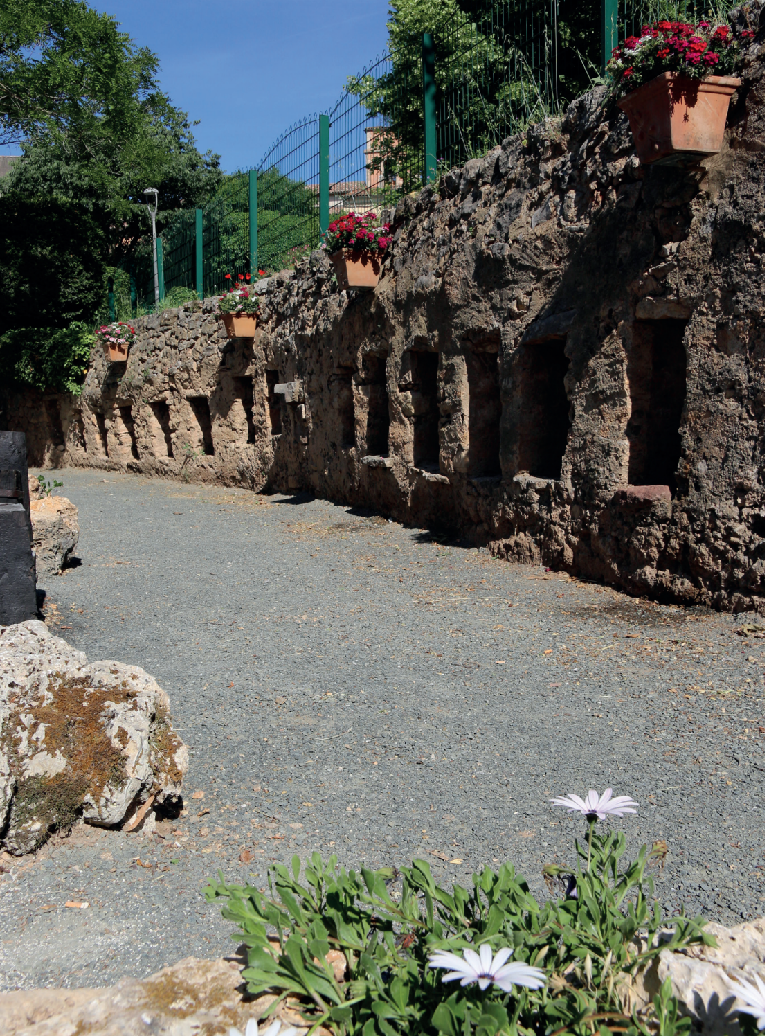
Le mur des Apiés (mur à abeilles) de l'ancien jardin aux moines [ situé en face du Moulin à Huile ]
